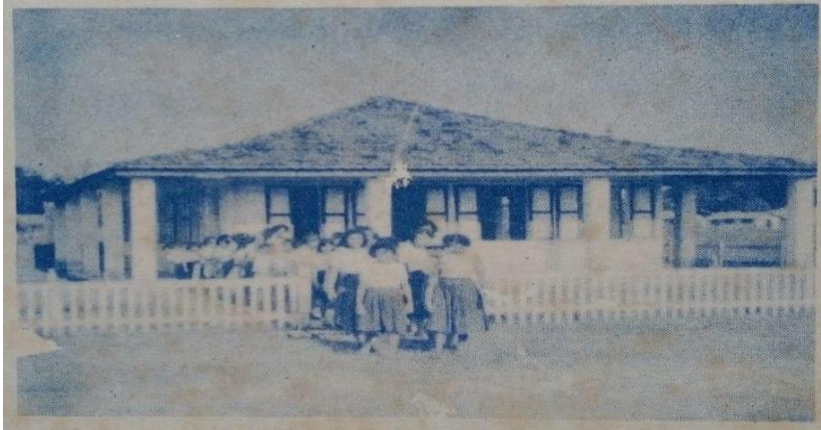
Figura 2 — Prédio do Internato Evangélico da Amazônia, onde ocorriam as aulas - 1948-1971.
