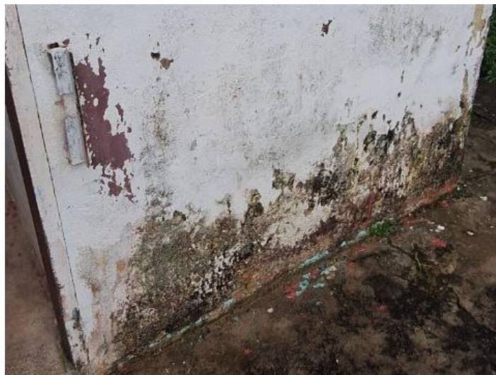
Figura 39 – Foto de levantamento da Área Externa e Frente da casa.
