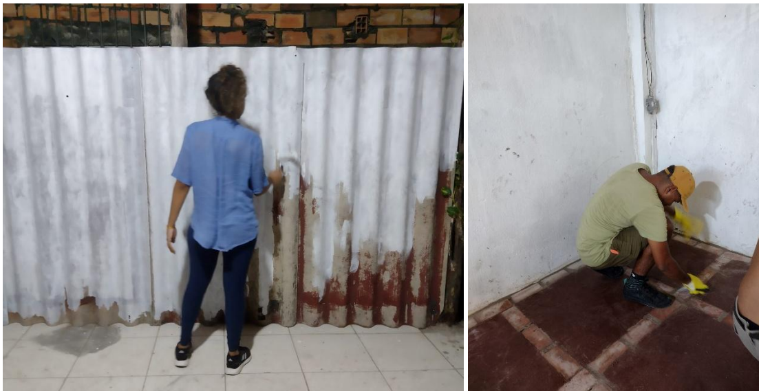
Figura 08 - Telha e azulejos sendo reaproveitados em reforma na Terra Firme, Belém-PA.
