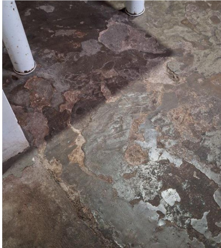
Figura 40 – Foto de levantamento do piso da casa.
