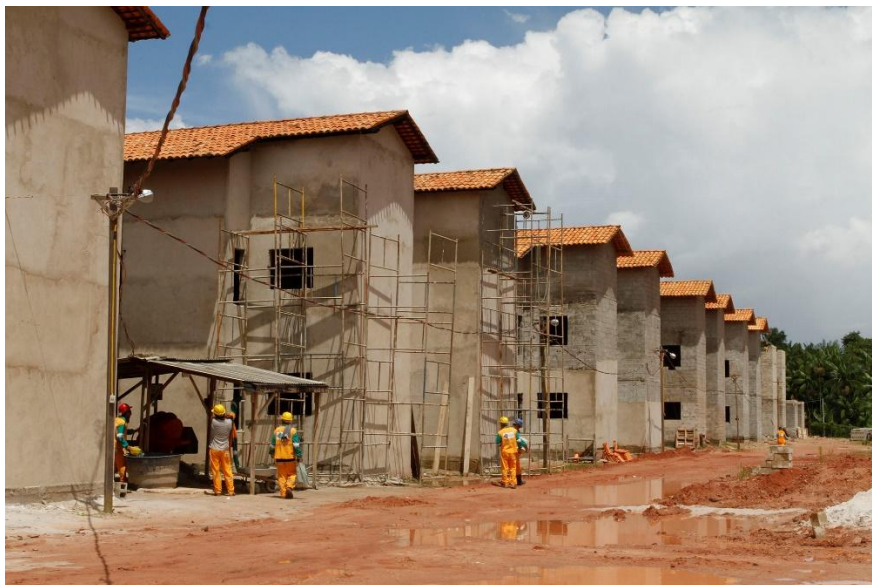
Figura 05 – Residencial Paracuri, localizado em bairro periférico de Belém.
