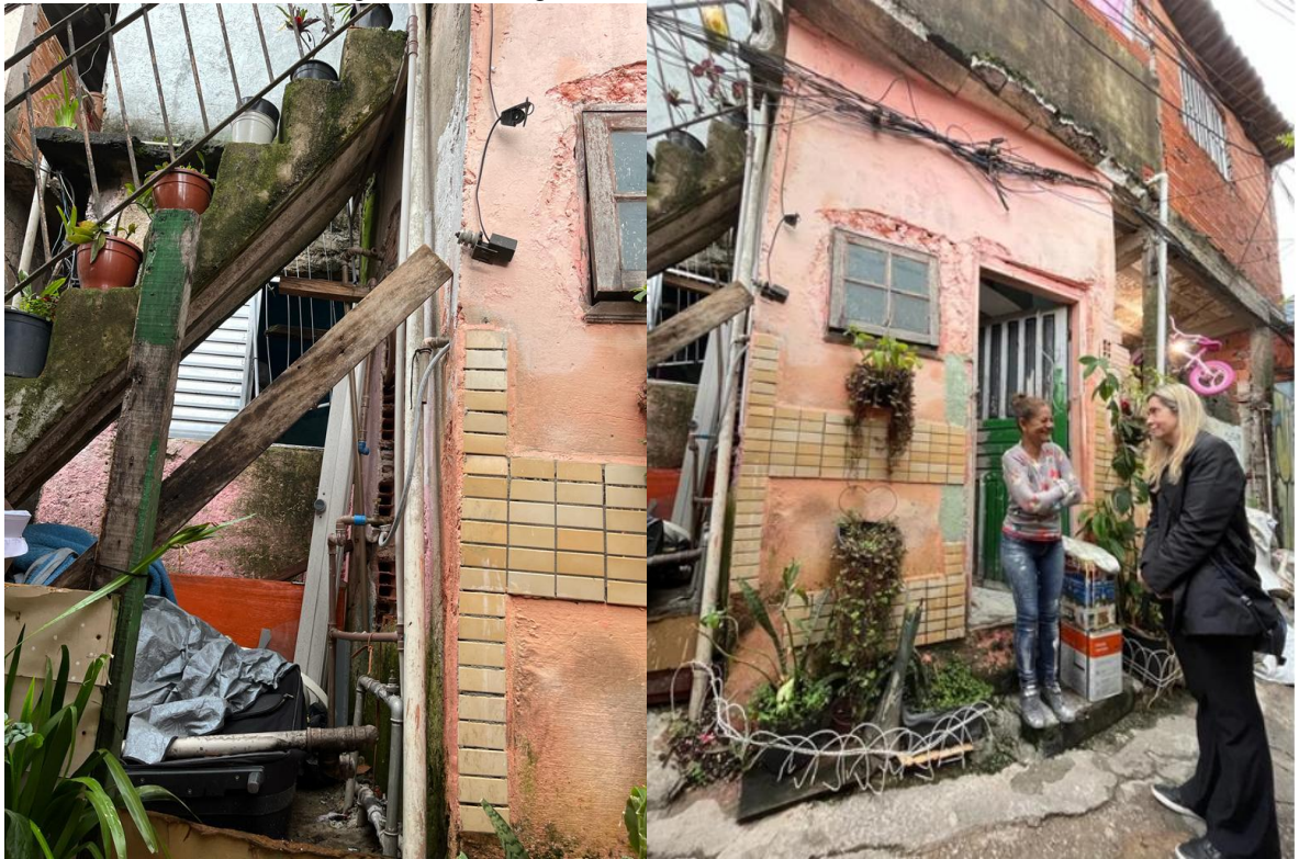
Figura 12 – Antiga fachada da casa do Francisco.
