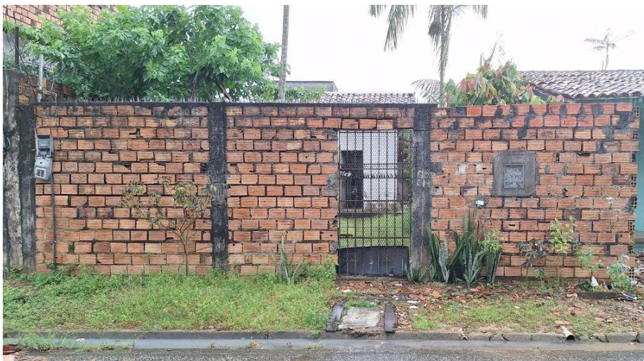
Figura 33 – Foto de levantamento da Fachada Externa.
