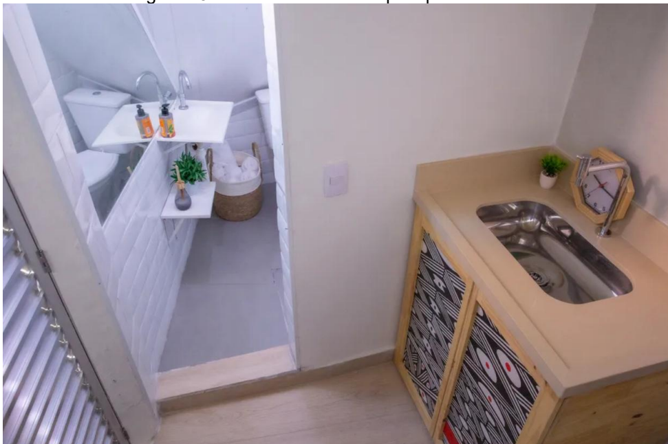
Figura 13 - Banheiro e área da pia após a reforma.
