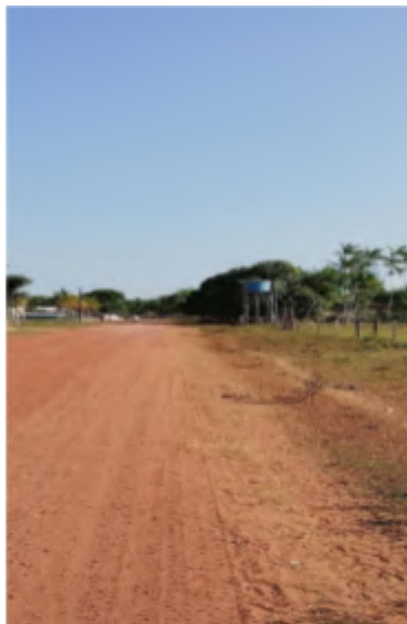
Figura 5. Centro da comunidade.
